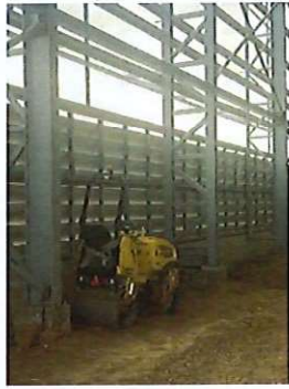
ภาพที่ 6 การจัดวางตำแหน่งอุปกรณ์ก่อสร้างที่อาจก่อให้เกิดเสียงดังในด้านที่ไม่ติดกับชุมชน
