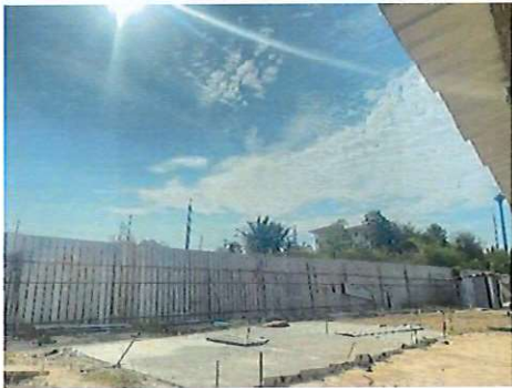
ภาพที่ 8 การกันรั้วพื้นที่ก่อสร้าง
