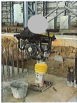
ภาพที่ 6 การจัดวางตำแหน่งอุปกรณ์ก่อสร้างที่อาจก่อให้เกิดเสียงดังในด้านที่ไม่ติดกับชุมชน
